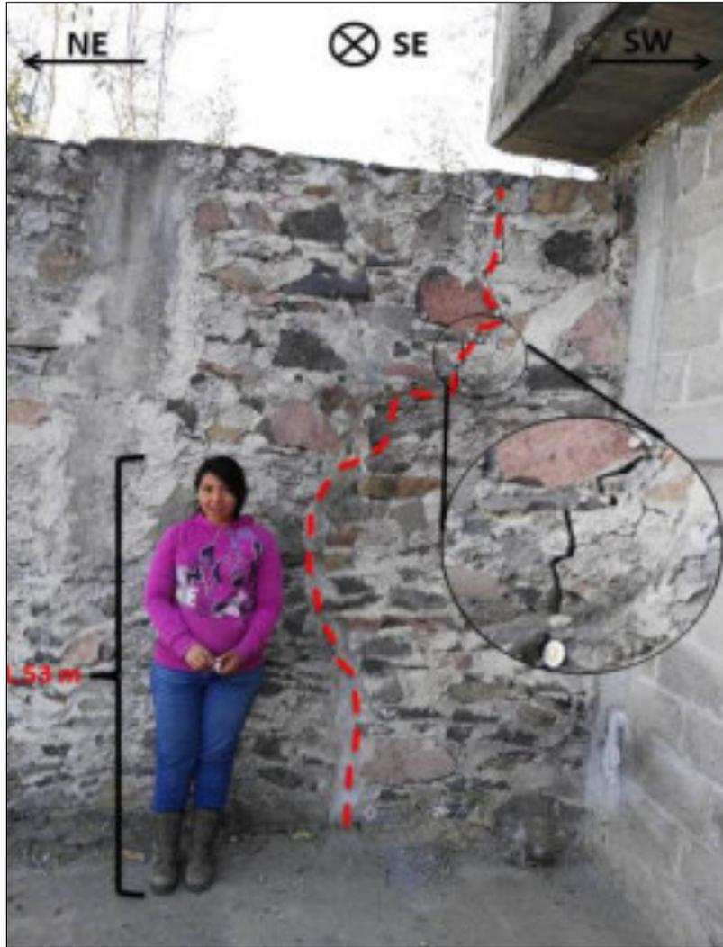
**Figura 5.17** - Agrietamiento en casa en comunidad San Agustín Mextepec, la grieta (Línea segmentada) está orientada NW-SE.
