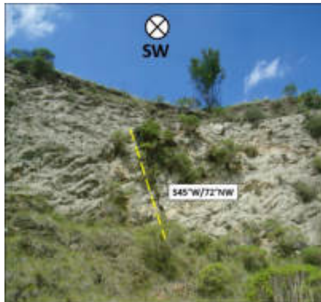
Figura 5.7 Falla con actitud estructural S45^{\circ}W, 72^{\circ}NW , que afecta los flujos piroclásticos de bloques y ceniza (punto de observación FI80).
