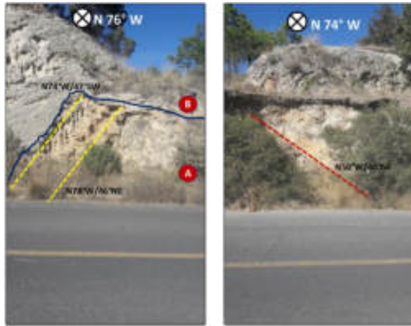
Figura 5.8 Fallas NW-SE en la zona de San Lorenzo Toxico. En figura de la izquierda se muestran a las fallas NW-SE que afectan a depósitos piroclásticos de la unidad San Lorenzo Toxico: círculo A depósito de caída de ceniza y círculo B flujo piroclástico. La imagen de la derecha muestra una fractura en los depósitos de caída de ceniza con orientación N50°W (punto de observación F118).
