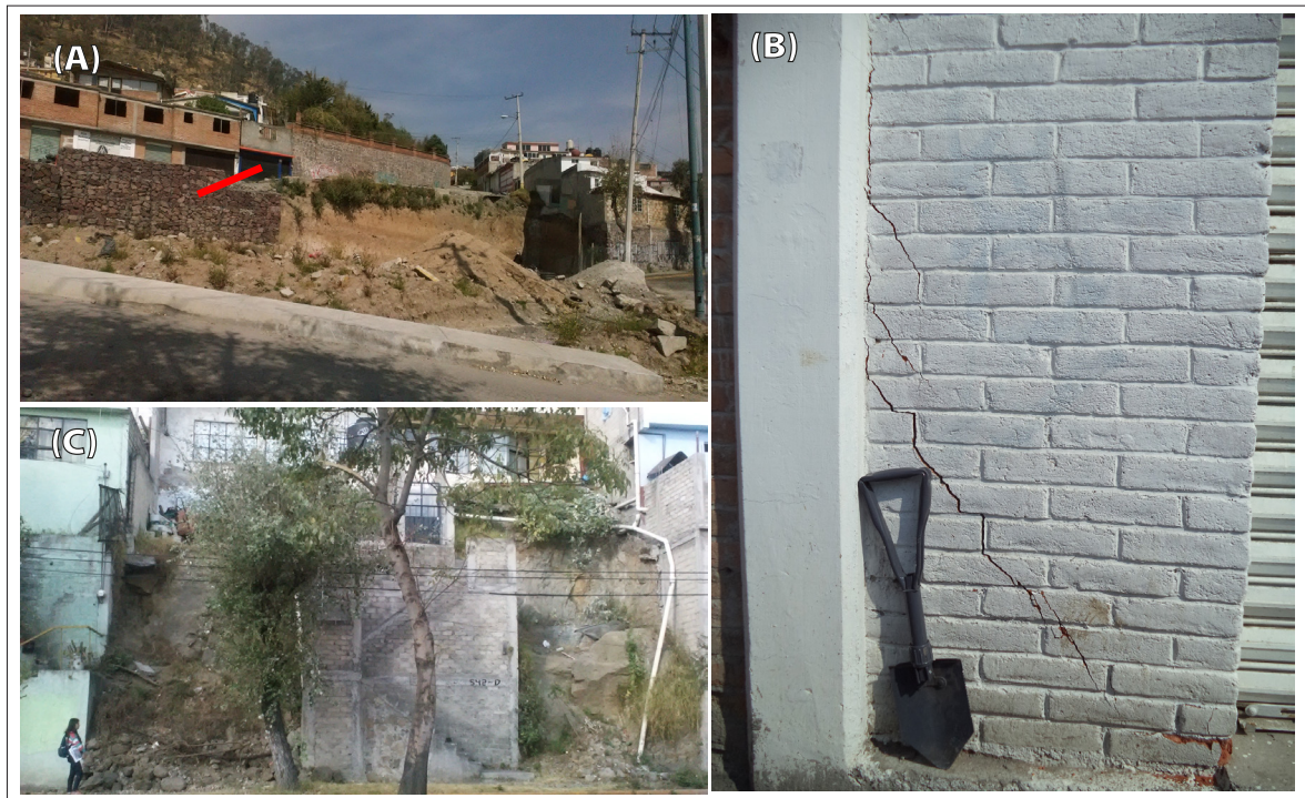
Figura 8. A: nivelación del terreno para la construcción de una obra en una zona de pendientes superiores a los 15°. Se indica con una flecha roja la aplicación de una medida estructural “Muros de gaviones” para evitar la ocurrencia de movimientos de ladera. B: grietas en paredes en construcciones adyacentes. C: desprendimientos de rocas que debilitan el sustento de viviendas, provocando el socavamiento de sus cimientos.
