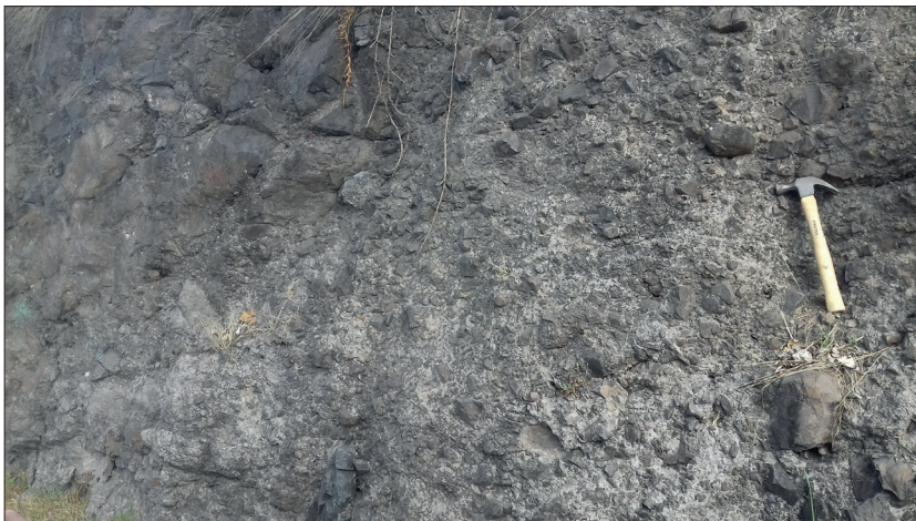
Figura 5. Taludes conformados por material piroclástico de composición andesítica.
