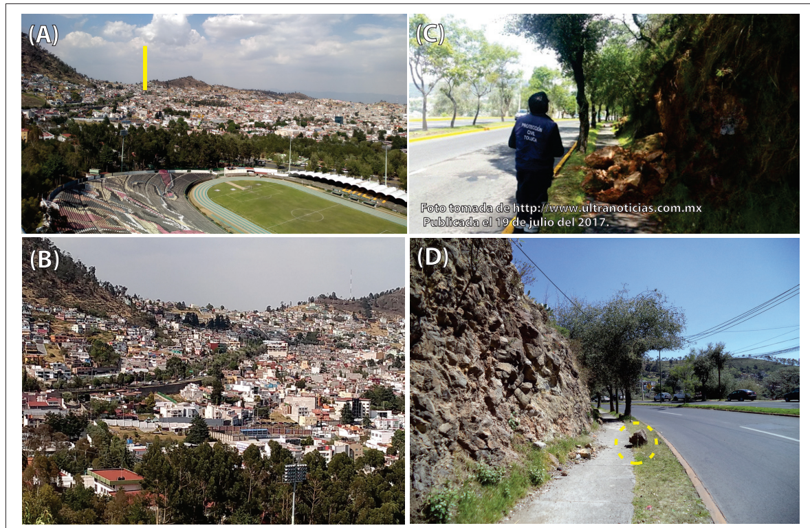
Figura 1. Área de estudio, donde: A: vista general del área, B: vista cercana de un sector con pendientes superiores a los 20^\circ , y C y D: impacto de los desprendimientos rocosos sobre las banquetas (aceras) del Paseo de los Matlazincas.
