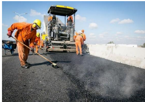
Figura 2. Puesta y tendido de mezcla asfáltica
