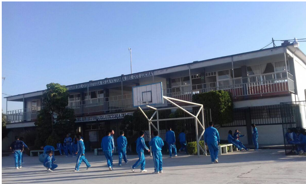
Figura 9. Fotografía de escuela con modelo U270 Fotografía propia.
