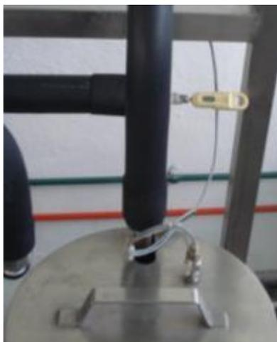
Fig. 3.50 Termómetro bimetálico portátil a la salida de la camisa doble
