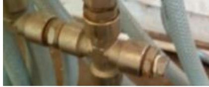
Fig. 3.54 Tapón, ubicado debajo de los medidores de flujo
