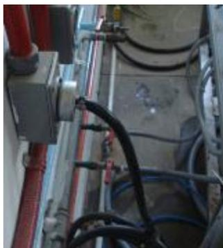
Fig. 3.31 Conexión de la cuba térmica a la electricidad
