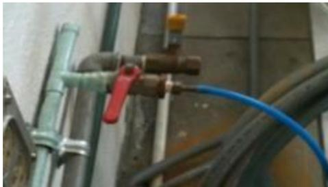
Fig. 3.26 Válvula de suministro de aire comprimido
