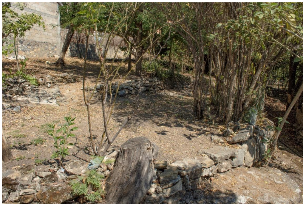
Fotografía 42. Construcción de terrazas para el cuidado del suelo
