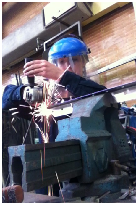
Corte de estructura de acero
