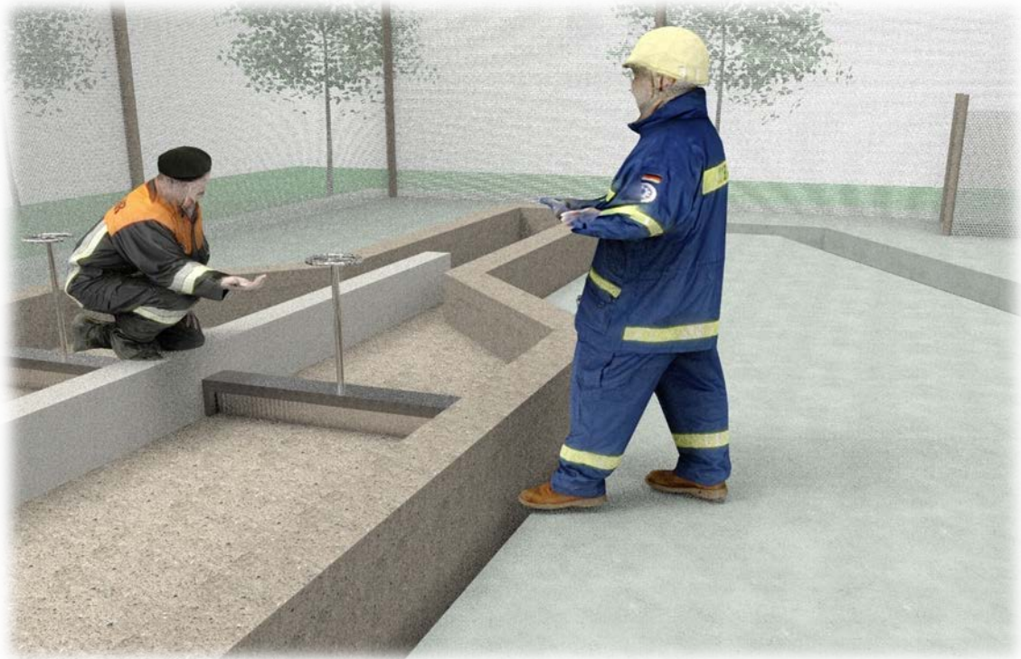
Figura 6.6. Mantenimiento en vertedor tipo Parshal
