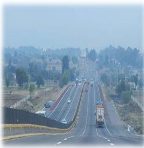
Figuras 4. 13 y. Autopista México Puebla Fuente: Propia (2014).
