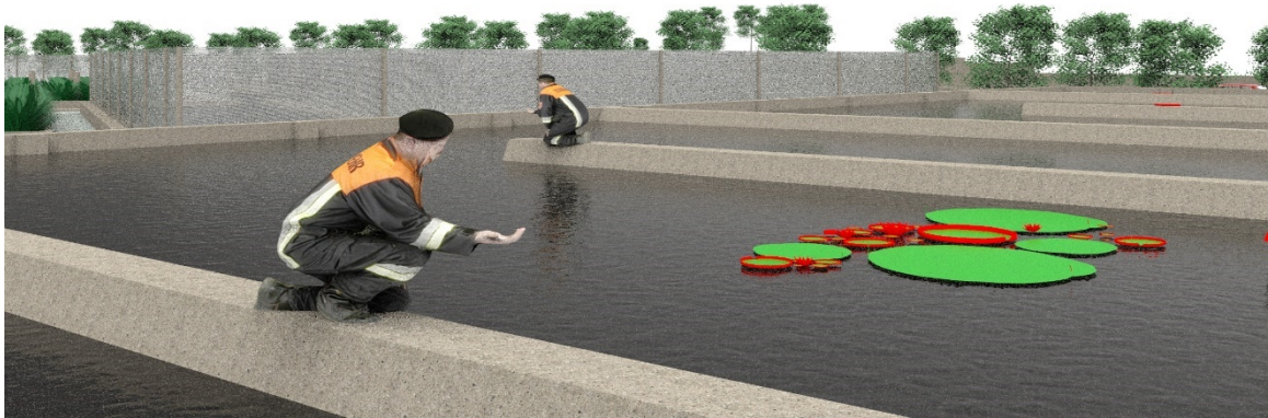
Figura 6.12 Mantenimiento en la laguna de maduración
