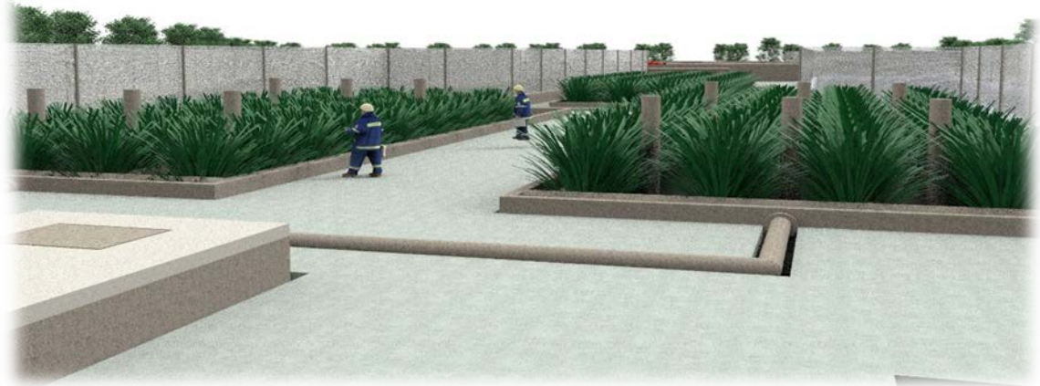
Figura 6.8. Sedimentador y humedales
