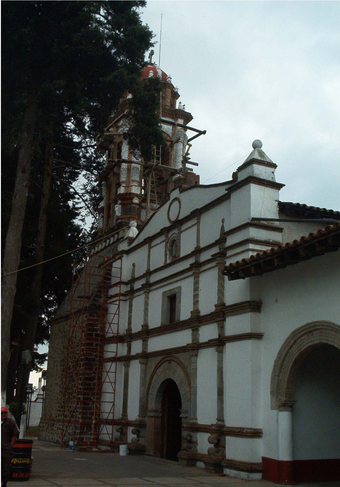
Templo de Santa María Nativitas Tarimoro. Torre en restauración.
