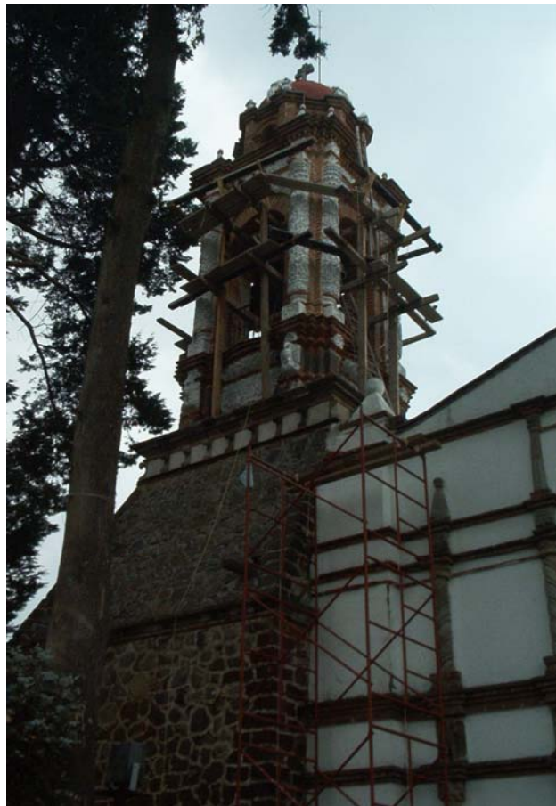
Torre barroca en argamasa. Iglesia de Santa María Nativitas Tarimoro.
