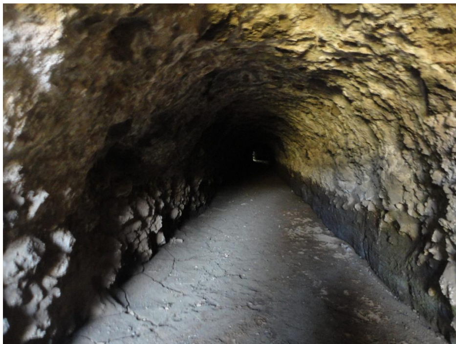
Fotografía 3. Primer sifón del Sistema Hidráulico, excavado para sortear una elevación del terreno.
