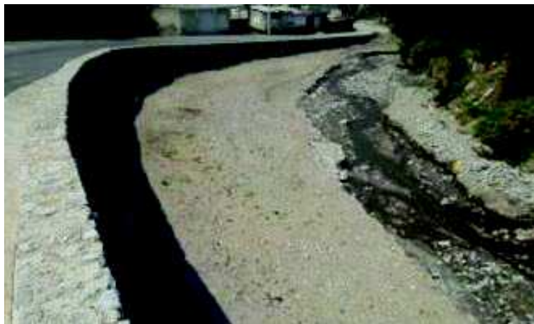
Figura 1.1. Obra de protección en margen de un río.
