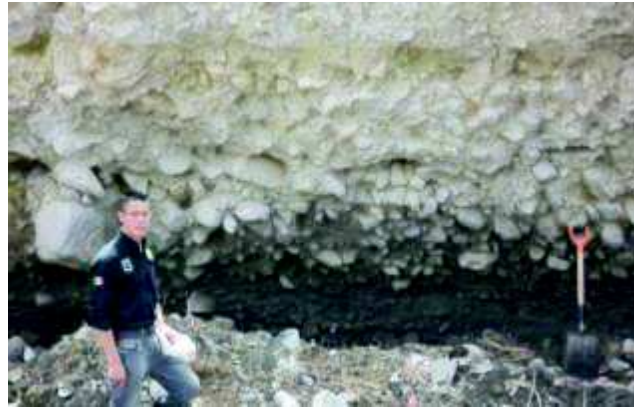
Figura 6.16. Depósitos de sedimentos en las márgenes del río Las Cruces, indicando la capacidad de transporte.
