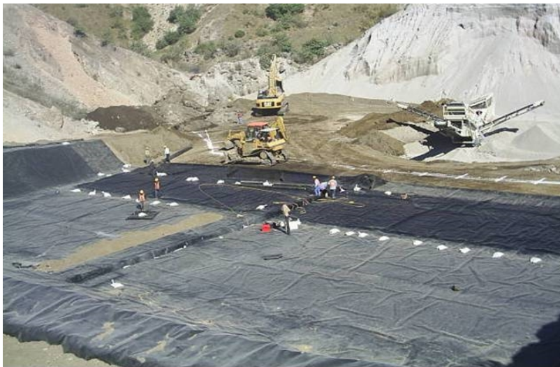
Figura 5. Impermeabilización del relleno sanitario “La Estación de San Antonio”
