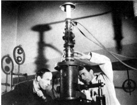
Figura 1.10 Ruska y Knoll construyendo el primer TEM [83] .
