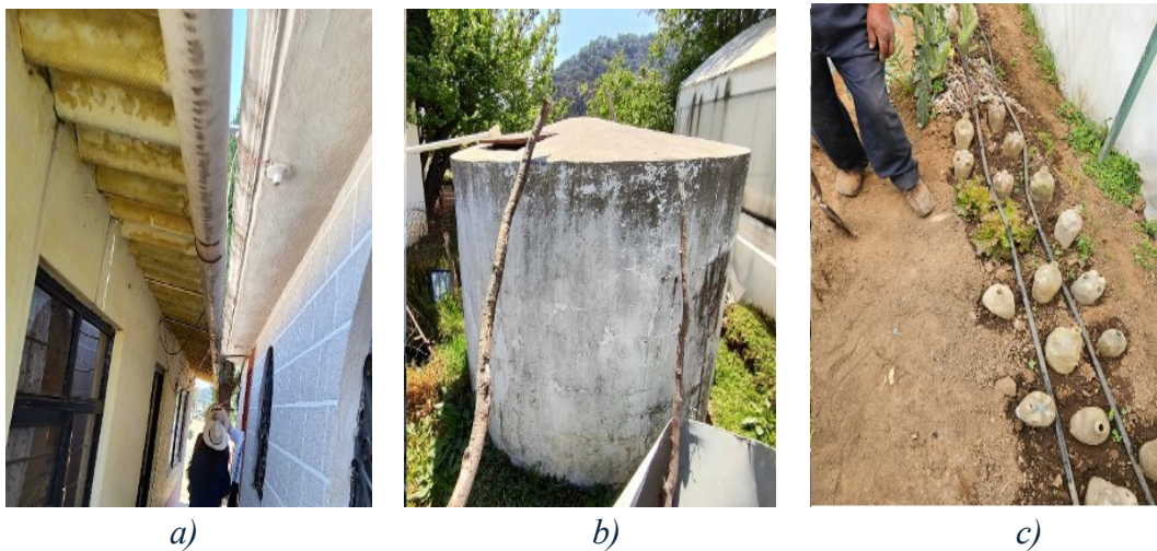
Figura 1.1 Sistema de Riego por Goteo de una Estación de Producción de la asociación de pequeños productores TONAEM Villa del Carbón, 2024. a) Sistema de captación de agua pluvial. b) Depósito de agua pluvial con capacidad de 10,000 lts. c) Sistema de riego por goteo
