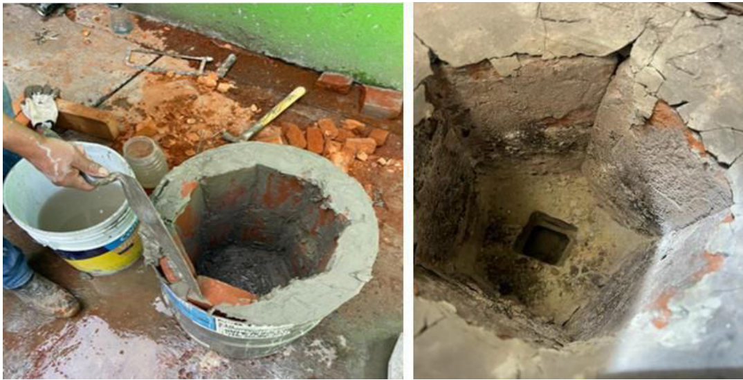
Figura 24. Colocado del ladrillo refractario en el interior del horno y revestimiento interior del tambor de acero con mezcla de concreto resistente a alta temperatura.
