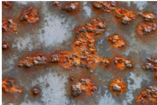
Figura 10. Demostración superficial de la corrosión localizada (Parra, 2018).
